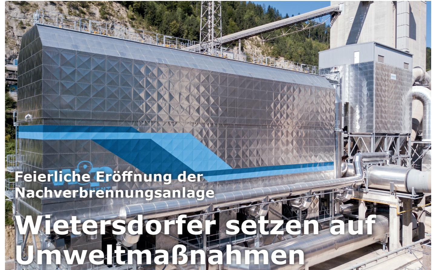
Die neue Nachverbrennungsanlage im Zementwerk Wietersdorf konnte Mitte September planmäßig fertiggestellt und in den Produktionsprozess eingebunden werden. Nach einem ersten Probetrieb erfolgt heute die feierliche Eröffnung der Nachverbrennungsanlage, die zusammen mit der Staubfilter- und Quecksilberreduktionsanlage sowie der Schwefeldioxidbehandlungsanlage ein modernes Abgasreinigungssystem bildet, das neue Standards in der Zementindustrie schafft.
